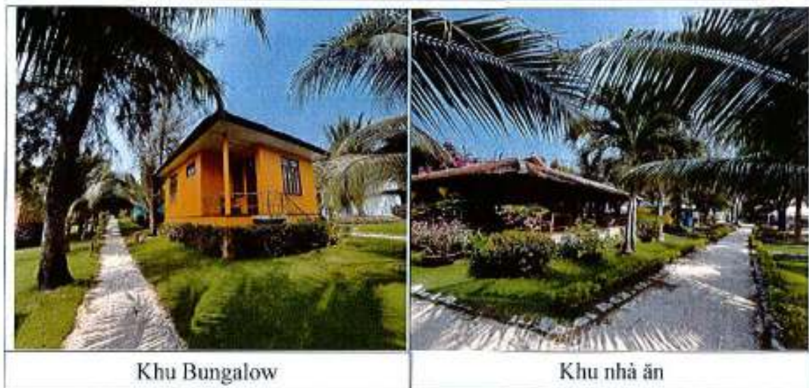
Hình 1.4. Các hạng mục công trình hiện trạng chưa được phá dỡ ở phía Nam dự án
